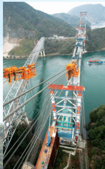
STEP 2 「三角ノ瀬戸」を跨いだケーブルクレーンは、支間、高さとも国内最大となりました。
