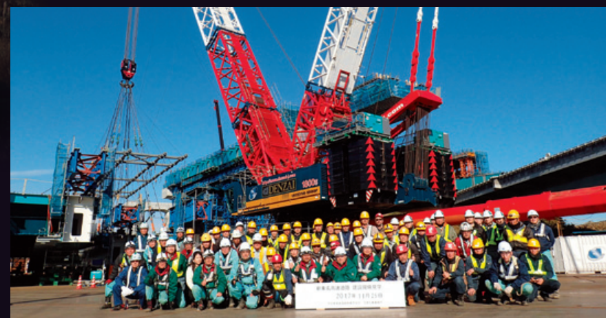
現場メンバーによる一括架設前の集合写真
