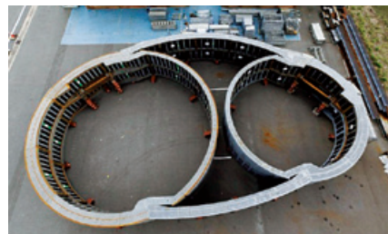
工場におけるセグメントの仮組立状況
