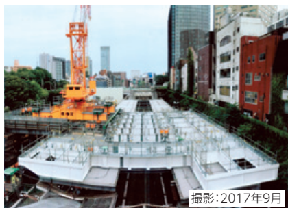
人工地盤上は駅コンコースとなる
