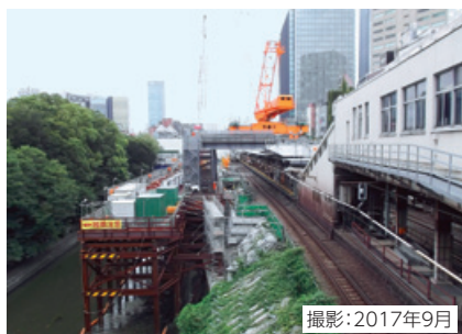
線路上空に人工地盤を構築
