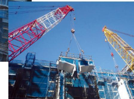
鋼製カルバートの部材をクレーンで吊り上げる
