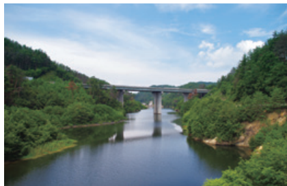
小仁熊橋全景
