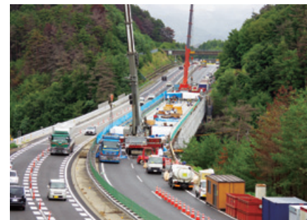
大型クレーンによる床版撤去
