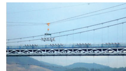
平成28年5月 ベルトコンベア架台撤去の様子
