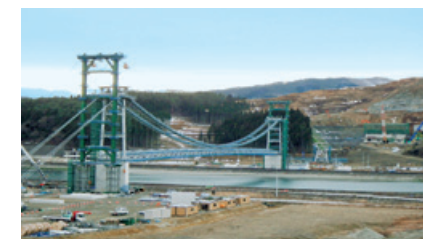
平成26年1月 架設時吊橋全景
