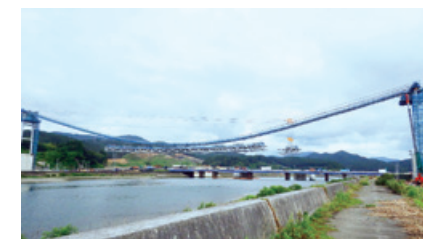
平成28年7月 補剛桁撤去の様子
