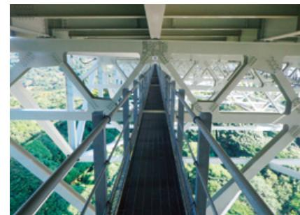
検査路の取替(完了後)
