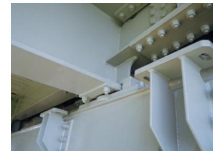
縦桁の支承取替(完了後)
