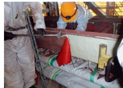
電磁誘導加熱による塗装剥離
