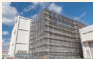
中高層用仮設足場
