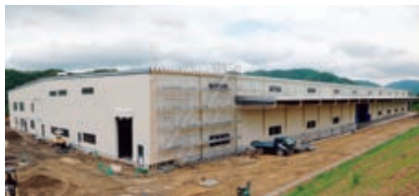
竣工間近の福知山物流センター
