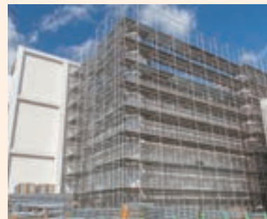
中高層用仮設足場
