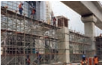
当社足場施行現場
