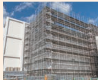
中高層用仮設足場
