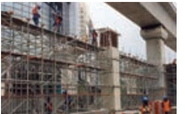
当社足場施行現場
