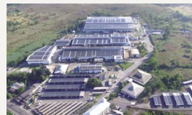
100%再エネ化を実現しているGROHEの水栓工場(タイ)
