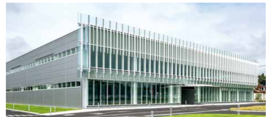
住宅・ビル用サッシ、玄関ドアの新たな研究開発センター「LIXIL Housing Technology R&D Center」(千葉県野田市)2017年10月開設
