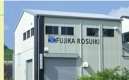
フジカ濾水機(株) 川口営業所・工場の外観
