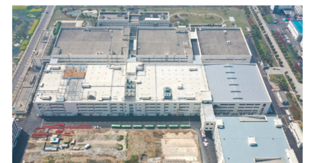
上海工場2期工事
