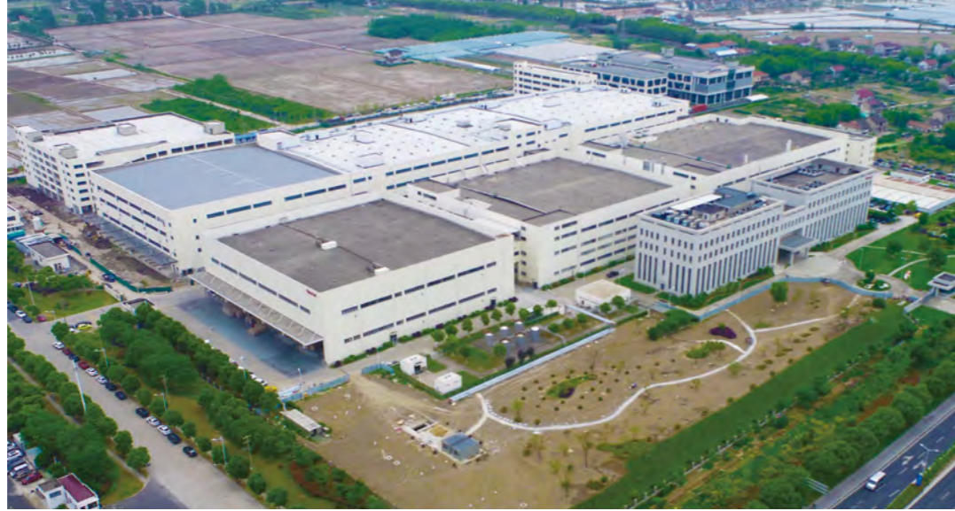
上海工場2期工事
