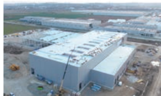
建設中の工場
