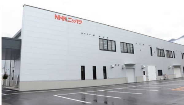
新設された伊那第二工場
