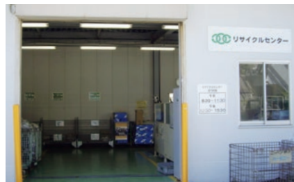
リサイクルセンター外観
