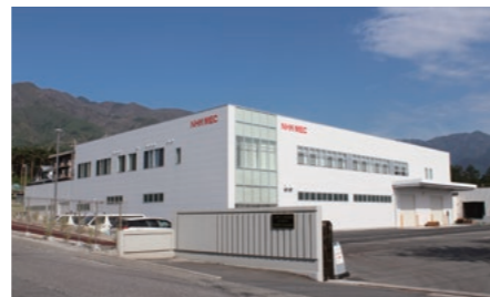
完成したメックの新棟
