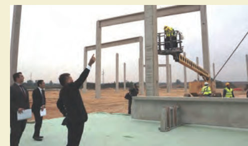
建設現場で行われた梁上式
