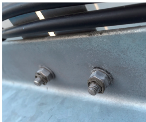
太陽光発電設備に取り付けられたロックワン
