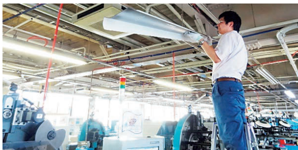
LED 蛍光灯への転換
