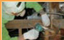
地震に備えて、基礎の強度回復を図るとともに、表面劣化を抑制する基礎補修施工や、木造家屋の接合部を金物で補強する家屋補強システム施工などを行なっています。
