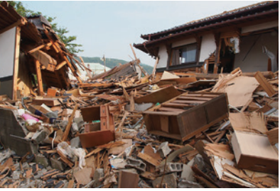
熊本地震の被害
