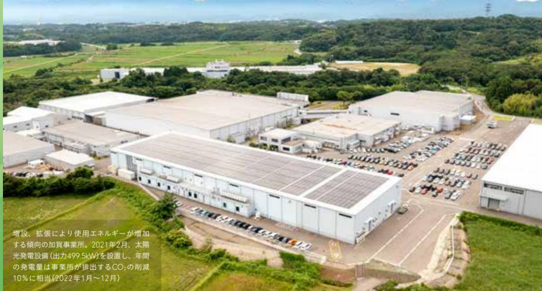
増設、拡張により使用エネルギーが増加する傾向の加賀事業所。2021年2月、太陽光発電設備(出力499.5kW)を設置し、年間の発電量は事業所が排出するCO<sub>2</sub>の削減10%に相当(2022年1月~12月)
