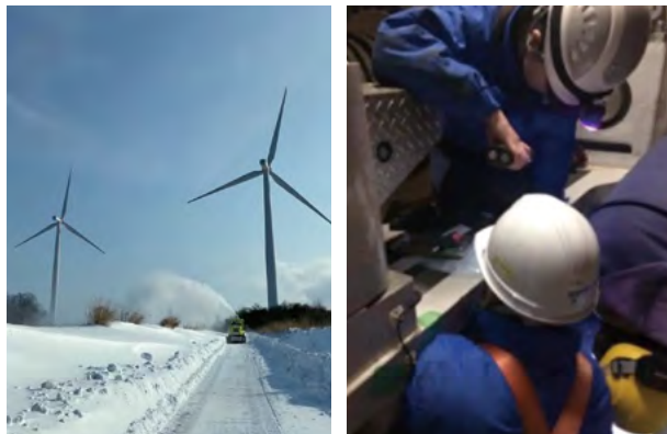
北海道道央地域で行った風力発電機実機での検証作業。 風車内部に入り、高さ70～80mまで登って検証機を取り付ける
