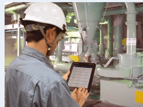
実証実験用システムを用いて、製品の運転データの「見える化」が可能に
