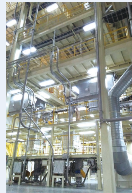
写真は納入先工場の外観と内部
