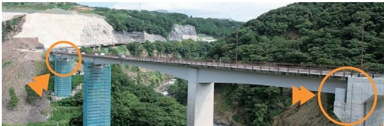
■コンパクトすべり支承 HPB設置位置【阿蘇長陽大橋（橋長276m）】
