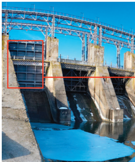
ローラーゲート型水門
