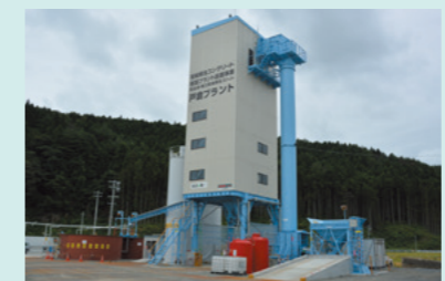
震災復興用プラントの投入
