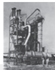
アスファルトプラント1号機 完成
