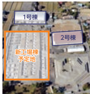
有明工場（長野県安曇野市穂高有明） 敷地面積：約51,600平方メートル
