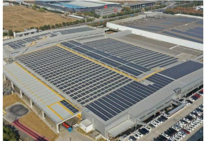
久保田農業機械(蘇州)有限公司(中国)では、工場棟の屋上に出力3.59MWの太陽光パネルを設置しています。これにより、2020年は約2,400t-CO<sub>2</sub>相当の発電を行いました。
