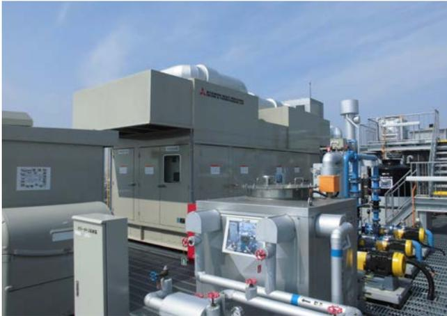
クボタ堺製造所では、自家発電時に生じた排熱を有効利用し、製造ラインで使用する蒸気ボイラーの燃料を削減するガスコージェネレーションシステムを導入しています。2020年度はこの取り組みにより、約370t-CO<sub>2</sub>のCO<sub>2</sub>排出量を削減しています。
