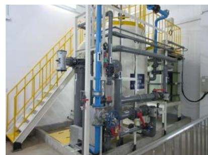
久保田農業機械(蘇州)有限公司(中国)では、工場全体の工程排水を再利用する再生処理装置を導入し、工程排水排出口を実現しています。2020年は約14万m<sup>3</sup>の水使用量を削減しました。
