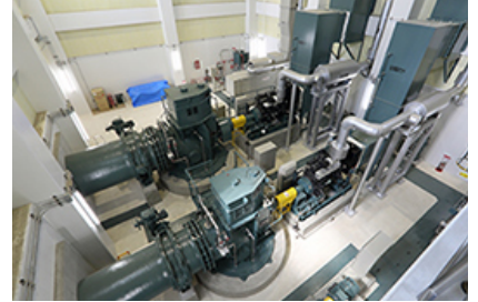
ポンプ(緊急排水をはじめ、大雨による浸水や高潮による浸水への対策として利用)
