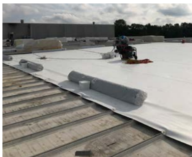
耐候性のある屋根材の設置(左)と設置後の屋根の様子(右)
