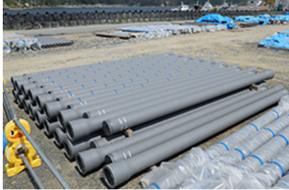
ダクタイル鉄管(水道・下水道・ガス管など、ライフラインの復旧・整備に活用)
