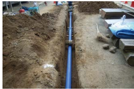
プラスチックパイプ 上下水道やガス管などのインフラに使用されます。
