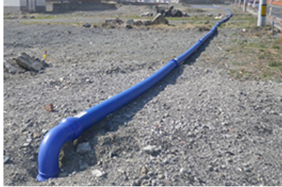
合成管(水道・下水道・ガス管など、ライフラインの復旧・整備に活用)
