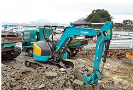
建機（瓦礫の撤去や各種土木工事などに利用）
