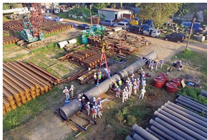
現地技術者への施工方法指導風景
