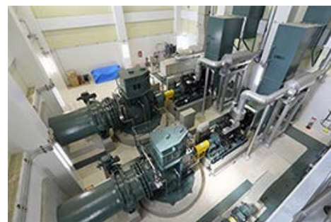
ポンプ（緊急排水をはじめ、大雨による浸水や高潮による浸水への対策として利用）
