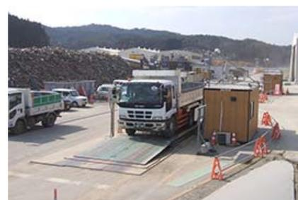
トラックスケール（トラックに積載された瓦礫などの重量を計測）
