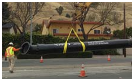
北米での耐震管「GENEX」試験施工
