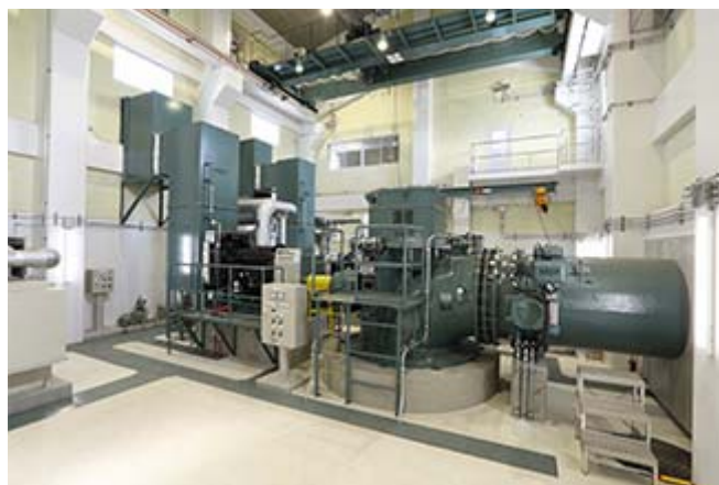
復旧したポンプ設備
