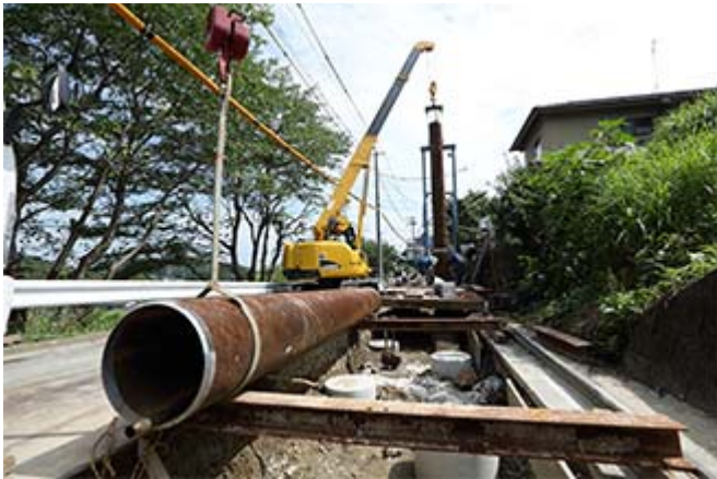
鋼管(基礎杭として橋梁基礎、港湾、河川、建築基礎など多方面に利用)
