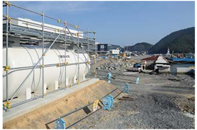
浄化槽(下水道が整備されていない地域、仮設住宅等の排水処理に活用)
