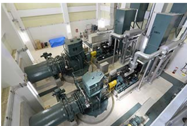
ポンプ(緊急排水をはじめ、大雨による浸水や大潮による浸水への対策として利用)
