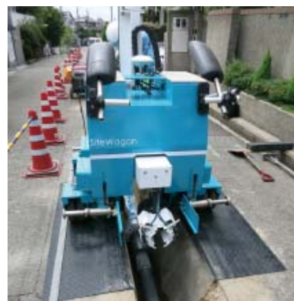
サイトワゴンによる配管施工
