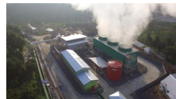
ディエン小規模地熱発電所
