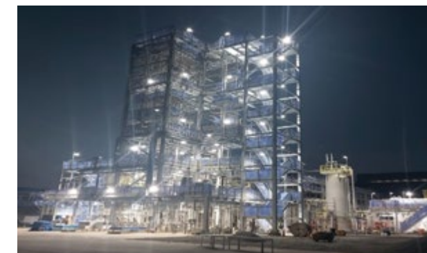
2023年完工 Dry Gasプラント
