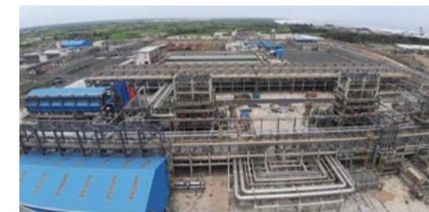
HPLNG社向けLNG再ガス化設備
