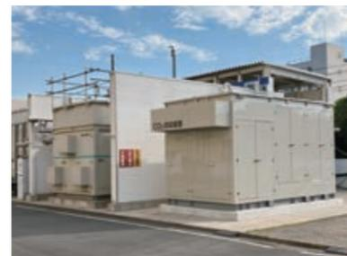
実証試験中のCO<sub>2</sub>回収装置
