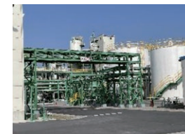
巨菱精密化学股份有限公司向けに設計・調達・建設を行った「過酸化水素製造設備」
