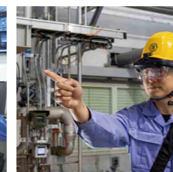
スマートグラスを活用した現場点検
