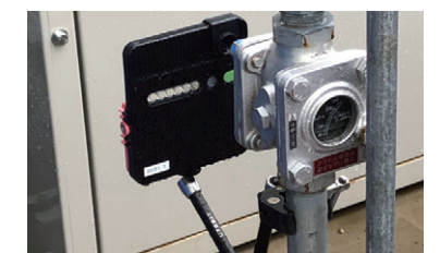
IoTカメラによる自動読み取り
