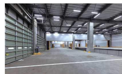
倉庫・トラックバース
