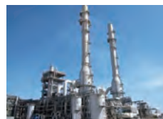
廃液燃焼システム
