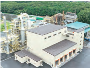
廃棄物処理設備
