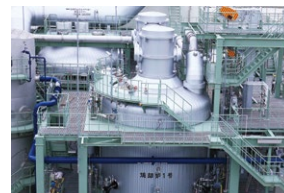
下水処理場向け汚泥焼却炉 (次世代型汚泥焼却システム)
