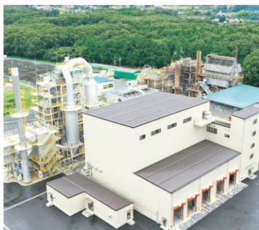
廃棄物処理設備
