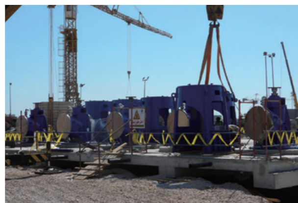
バハル・アル・バカル水処理プラントに据付中の処理水ポンプ
