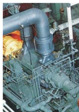
火力発電所向け高圧多段超臨界圧ボイラ給水ポンプ。(1974年)
