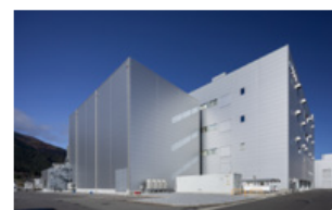
ワクチン製造設備外観
