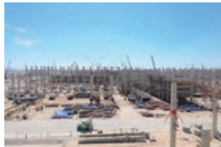
建設工事の様子 写真提供：カタールエナジー社
