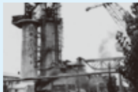
化学肥料工場向け搬送コンベヤ （パケットエレベータ）
