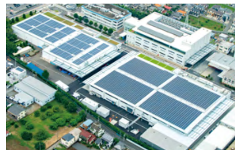
新工場棟では太陽光発電、省エネ生産方式を積極採用中
