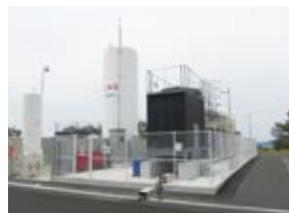
ガス発電による熱供給システム (岡山工場)
