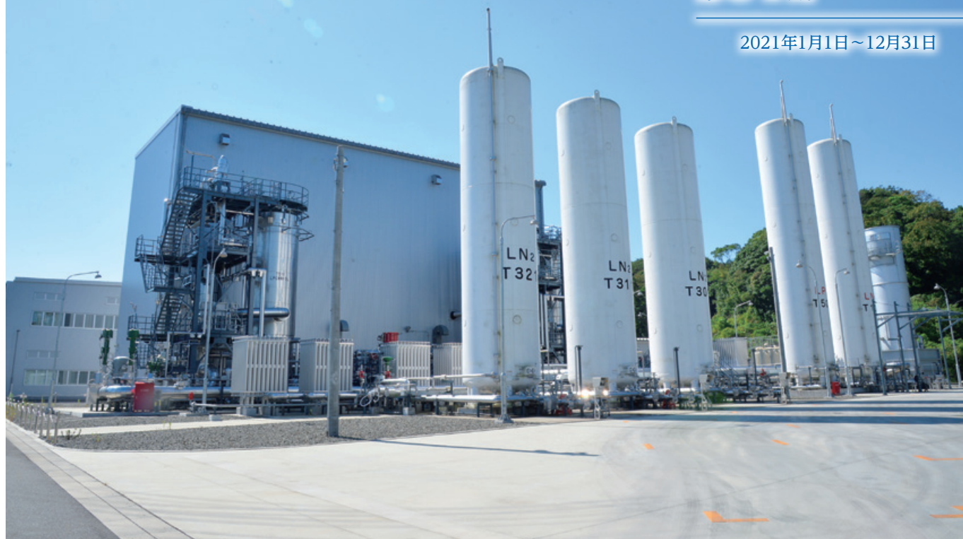
宮崎日機装 インダストリアル工場
